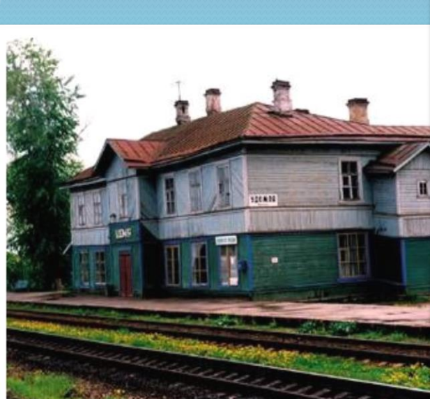
Удомля. Здание ж.д. вокзала Фото 1998 г.
